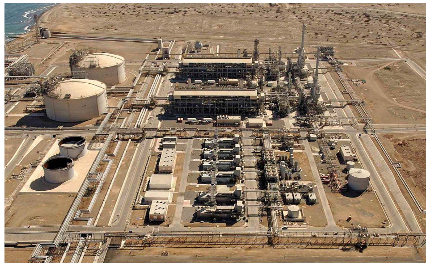
Aerial view of Oman LNG Plant
